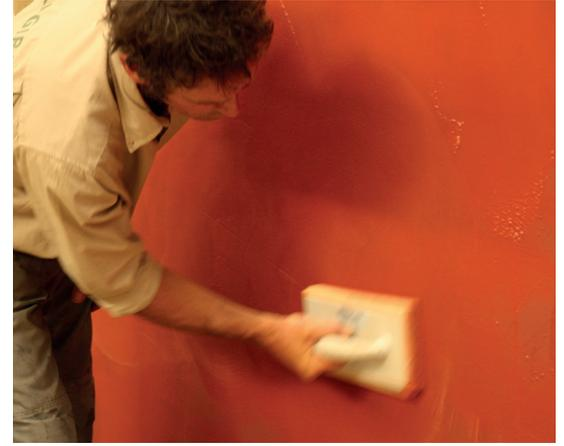
Pour une finition lisse, repassez à la plâtresse (plâtresse japonaise) directement après l'application de l'éponge, afin de resserrer le grain et jusqu'à obtenir une surface lisse.
