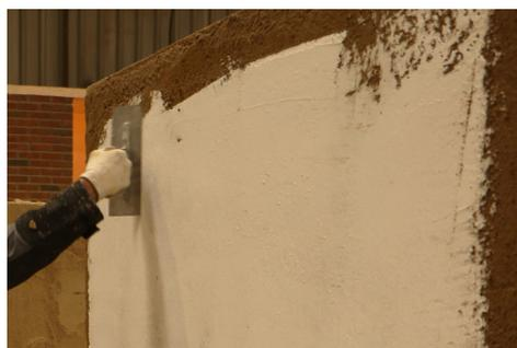
2) Laissez sécher jusqu'à ce que l'enduit ne marque plus au doigt.
